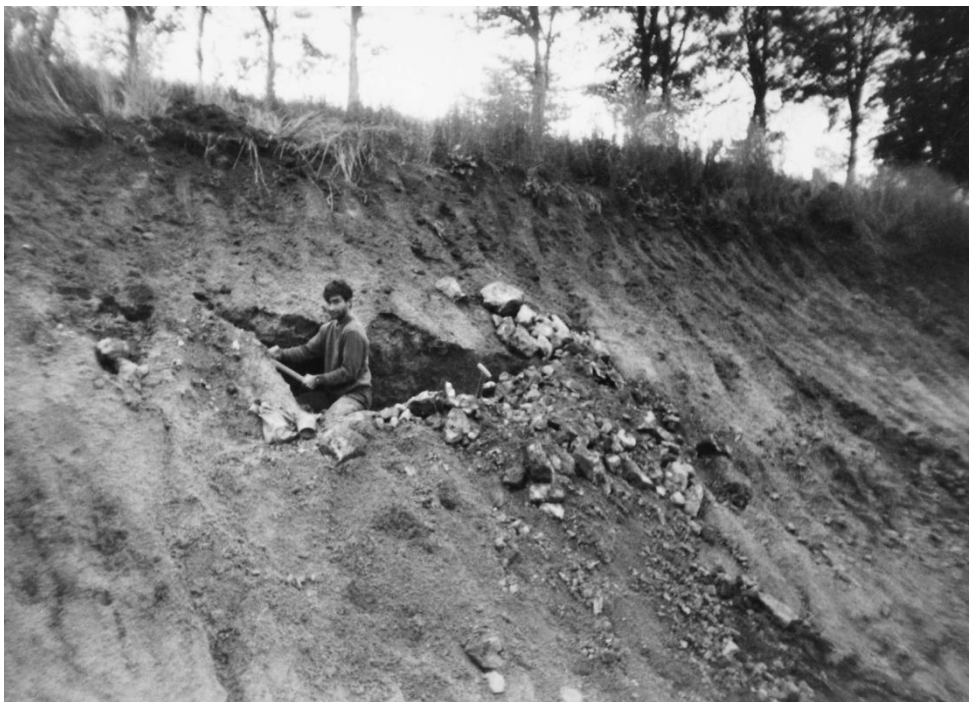
První výkopové práce na křemenné žíle v Liberci - Vesci, při rozšiřování komunikace R-35.
